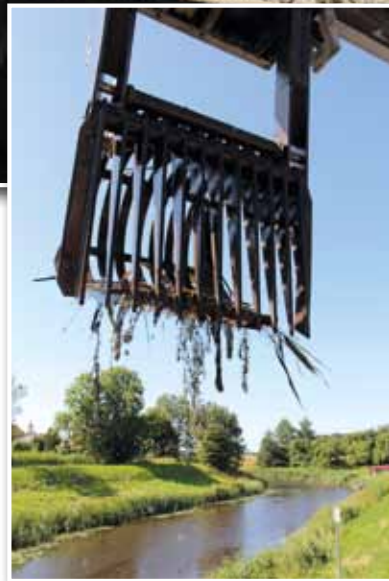
Spülschleuse im Neufelderkoog (gr. Bild). Das kleinere Bild zeigt einen Teil einer Rechenreinigungsanlage am Schöpfwerk St. Annen.
